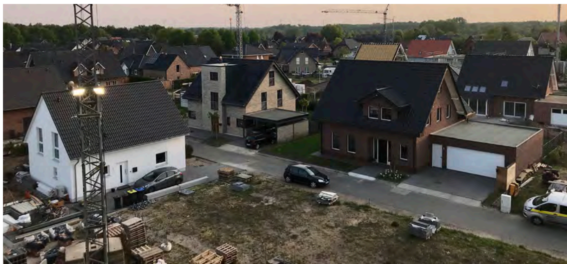
»» BAUGEBIET HOFFSTÄTTE: Auf Initiative der CDU in den Jahren 2015 bis 2018 Schritt für Schritt in Teilbereichen erschlossen.
