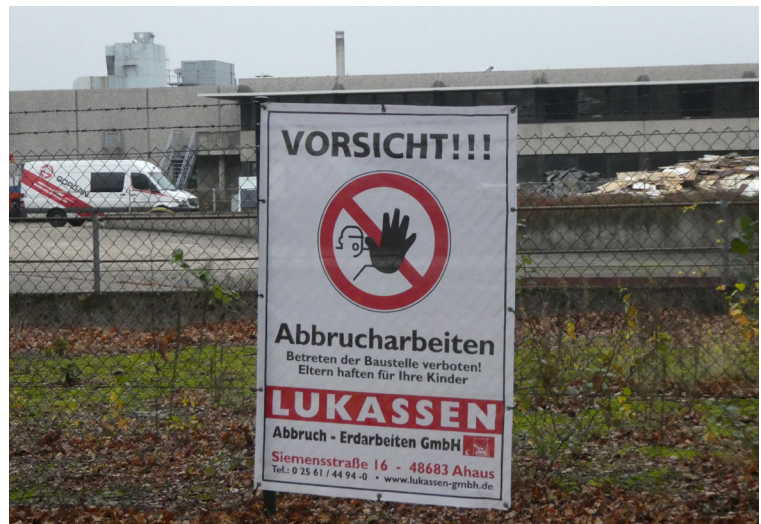
>>> EHMALIGES HÜLSTA GELÄNDE: Die Abbrucharbeiten haben begonnen. In den nächsten Monaten werden die Gebäude auf dem Areal abgerissen.
